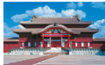
冲绳首里城 (用XYLAMON施工)
