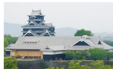
熊本城(キシラデコール・キシラモン施工)
